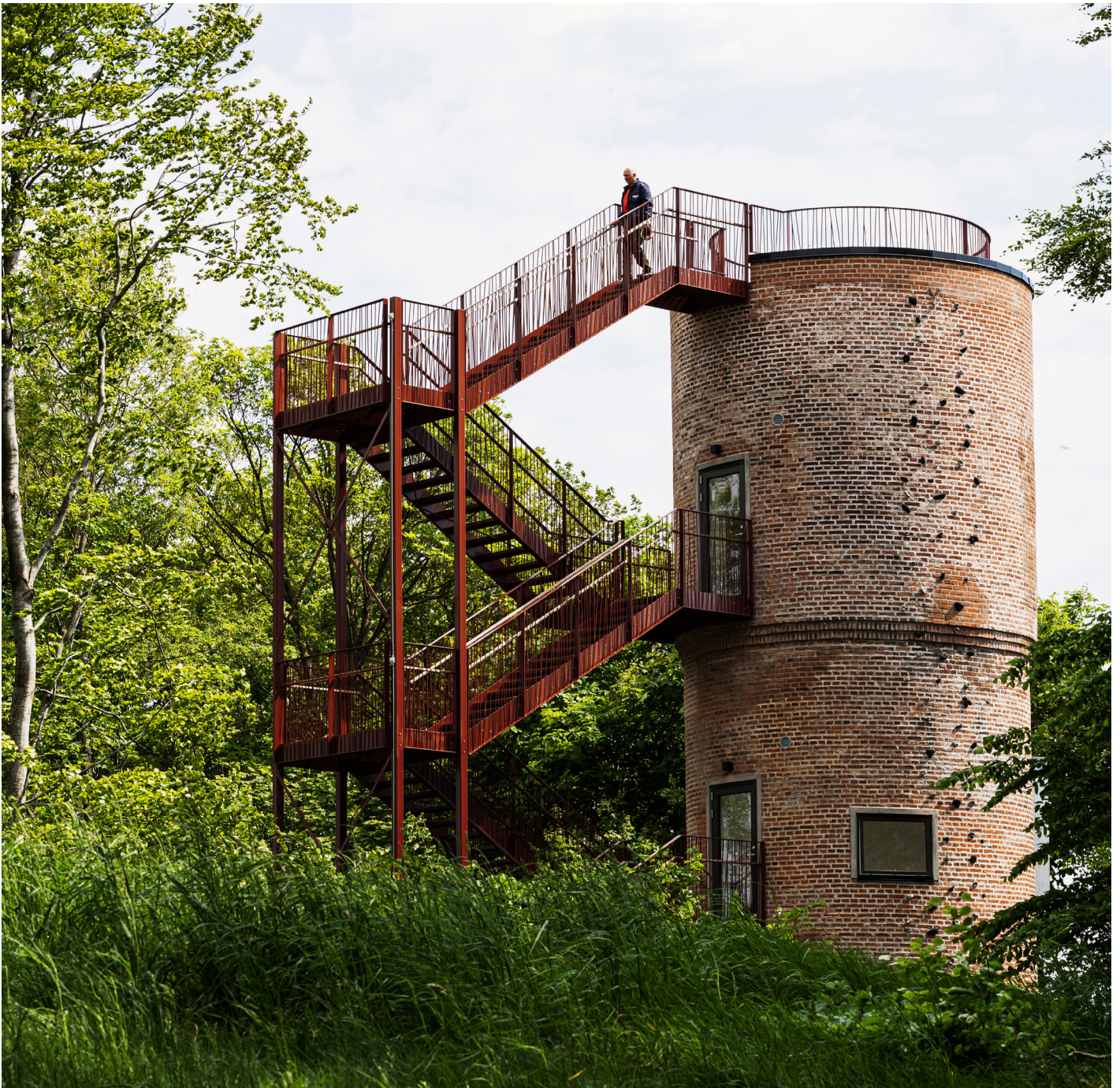
Billede: Tårs Vandtårn i Nordjylland. Forladt vandtårn transformeret af ERIK arkitekter til samlested for lokalsamfundet.
